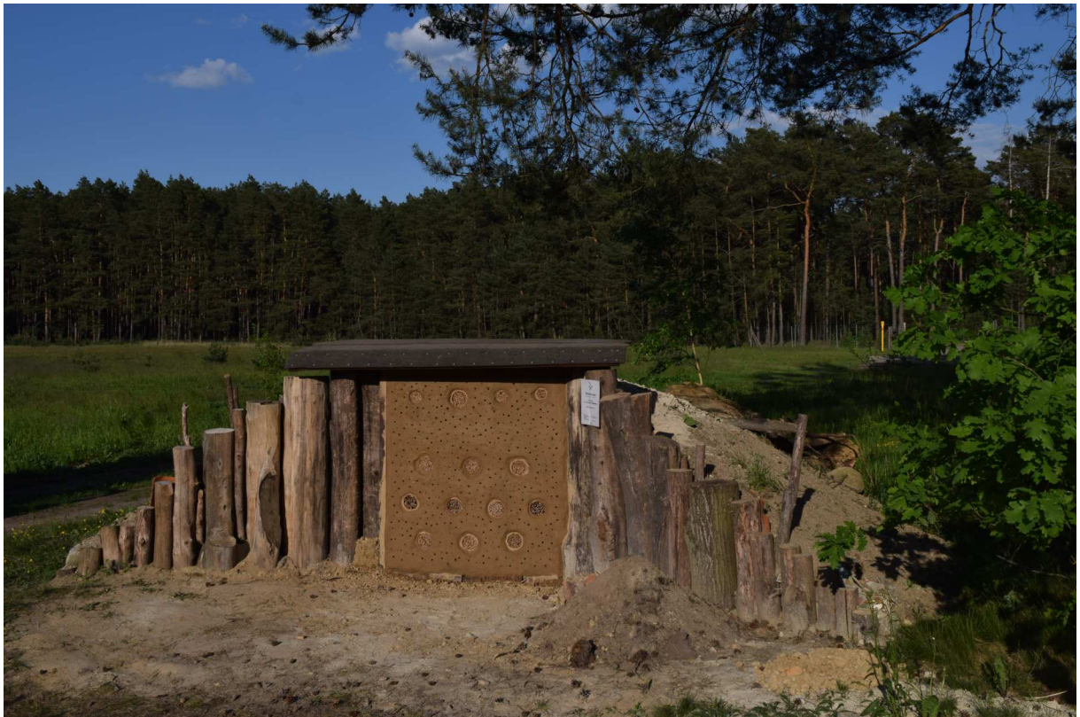
Abbildung 11: Mit fertiggestellter Lehmwand passt sich die Bienenburg auch in Frontansicht gut in ihre Umgebung ein.
