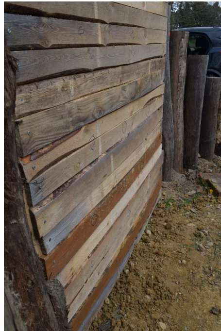
Abbildung 10: Wenn der Durchmesser der die Lehmwand begrenzenden Stämme geringer als die Länge der Tonröhren ist, kann mit Kanthölzern hinter der Verschalung die benötigte Wandtiefe hergestellt werden.
