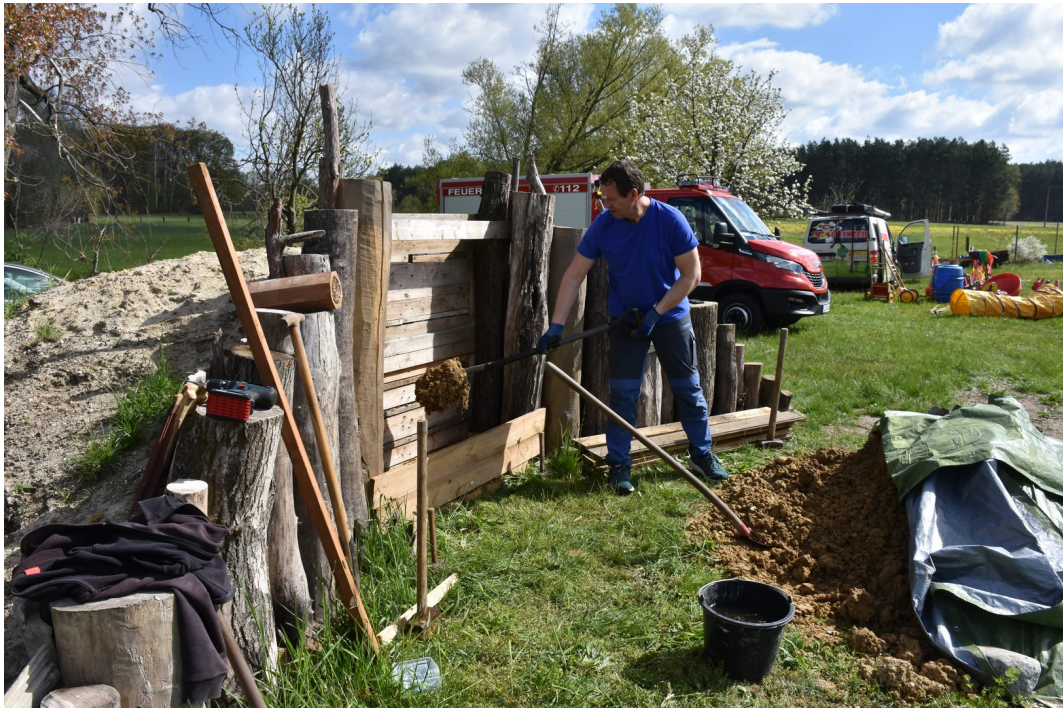
Abbildung 4: Nach dem Anbringen der untersten Schalbretter wird der Lehm für die erste Schicht eingefüllt.
