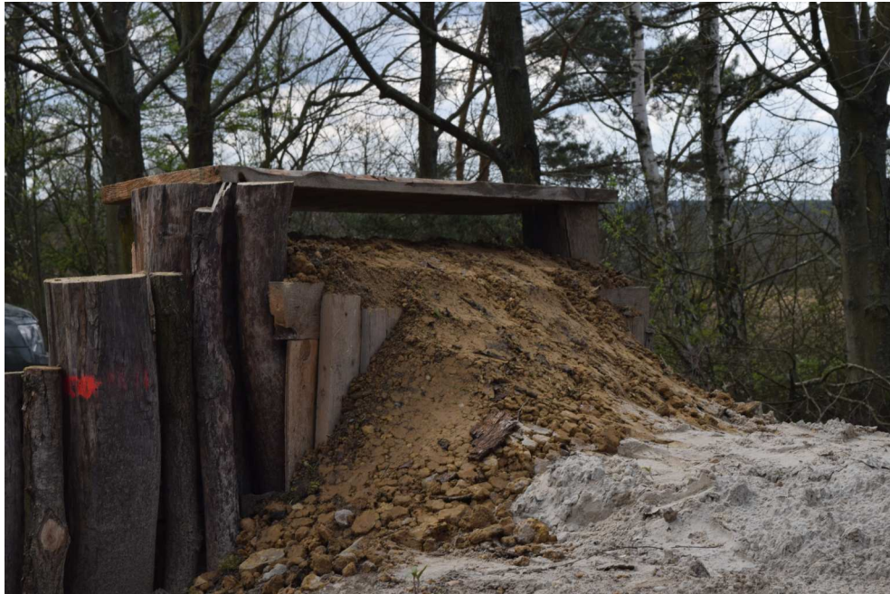
Abbildung 9: Zum Schluss wird Lehm zur Verkleidung von Konstruktionshölzern rückseitig an die Lehmwand angeeckt.
