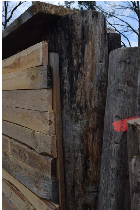
Abbildung 10: Wenn der Durchmesser der die Lehmwand begrenzenden Stämme geringer als die Länge der Tonröhren ist, kann mit Kanthölzern hinter der Verschalung die benötigte Wandtiefe hergestellt werden.
