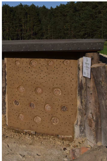
Abbildung 3: Dachkonstruktionen aus Dachpappe und abgewinkelter Unterkonstruktion.
