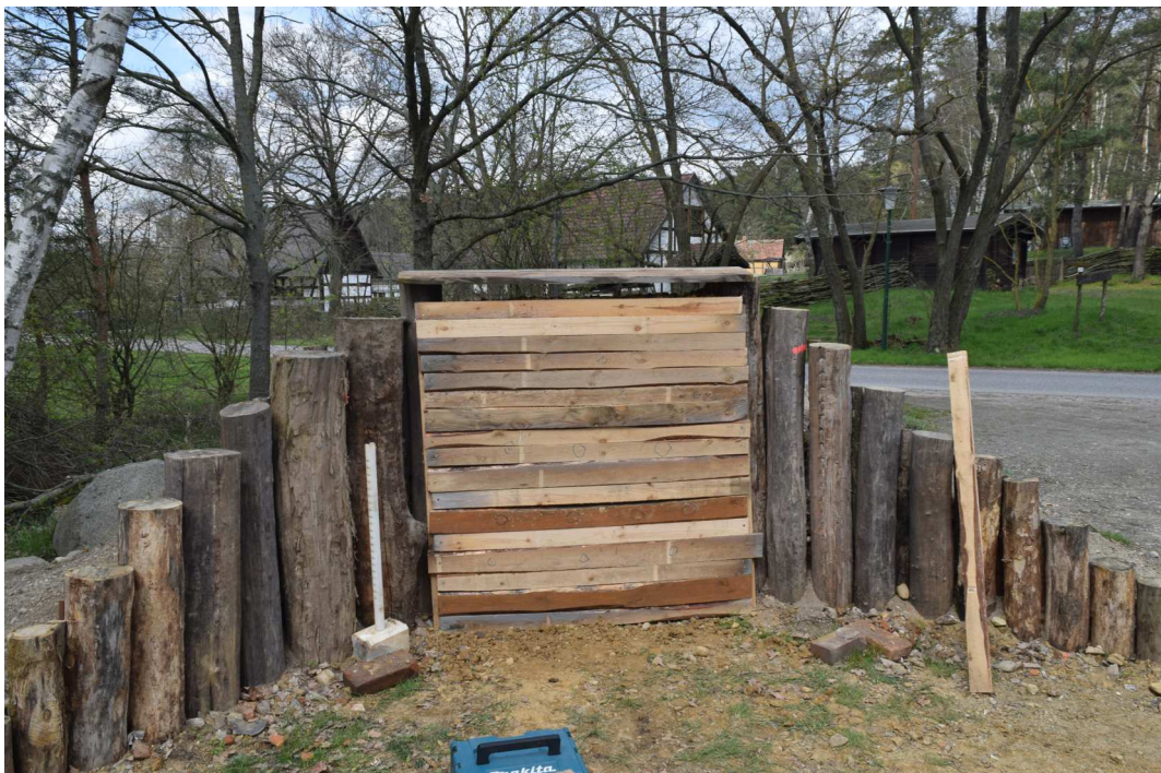
Abbildung 8: Fertig aufgezugene und verschalte Lehmwand.
