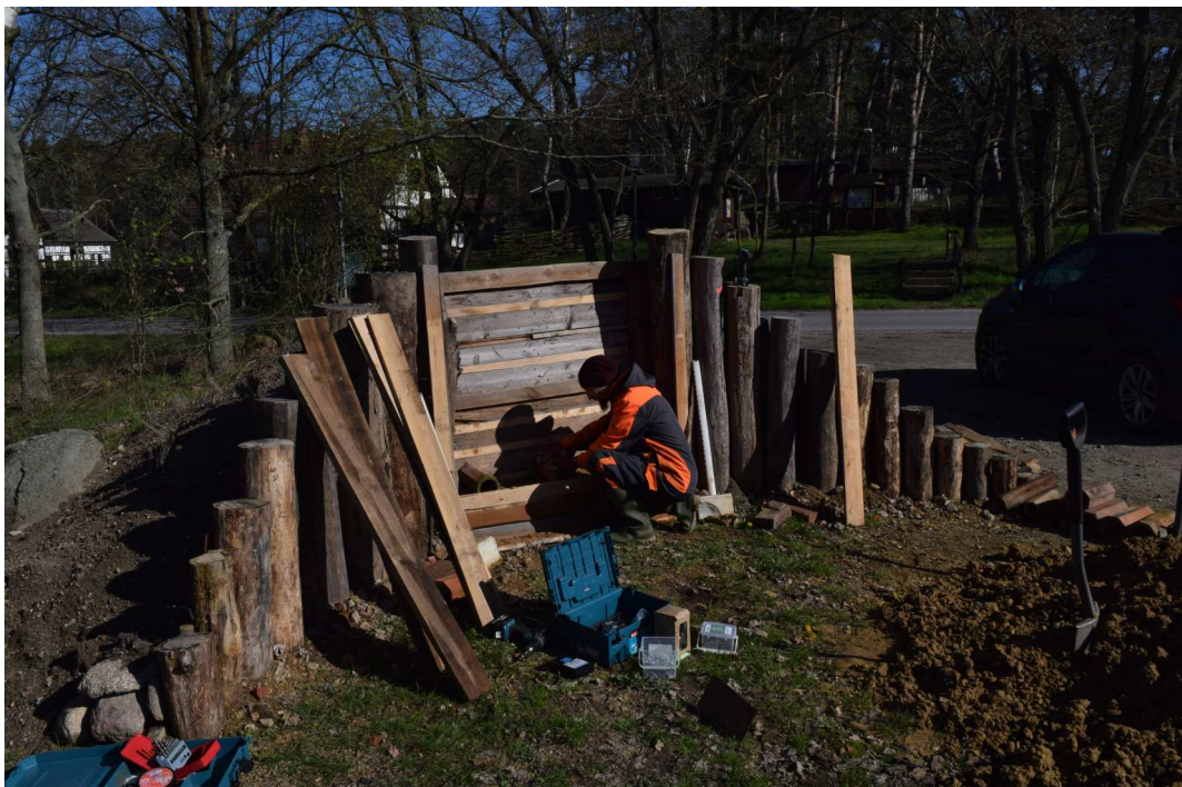
Abbildung 6: Lehm wird zwischen den Tonröhren mit der Hand verteilt und angedrückt.
