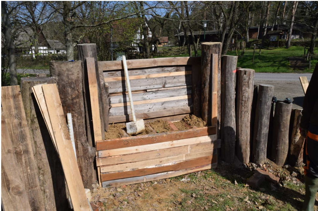
Abbildung 7: Oberhalb der Tonröhren kann der Lehm wieder mit einem Stampfer verdichtet werden.
