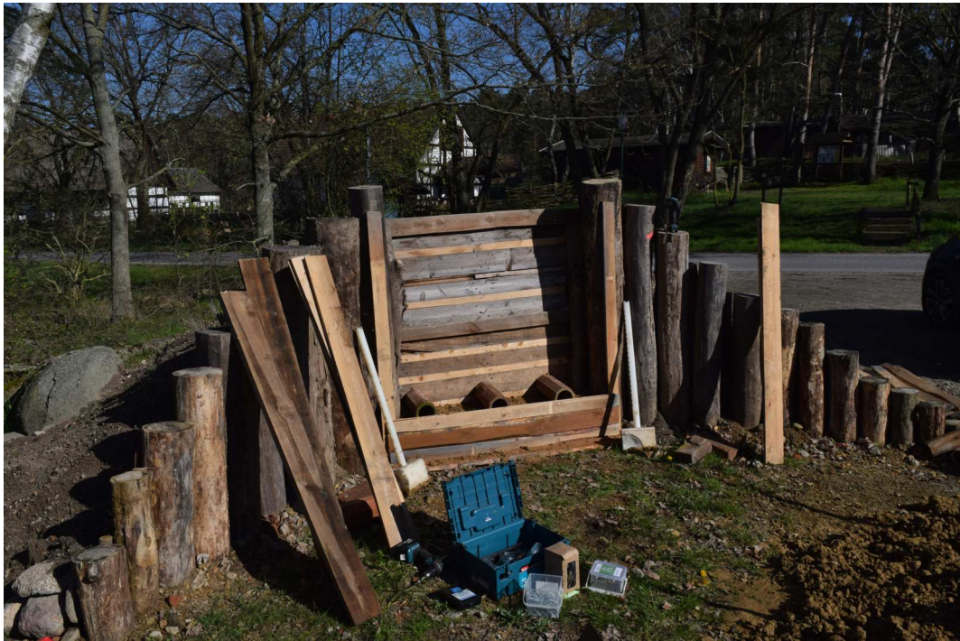
Abbildung 5: Die untersten Lehmschichten sind gestampft und Tonröhren eingelegt.
