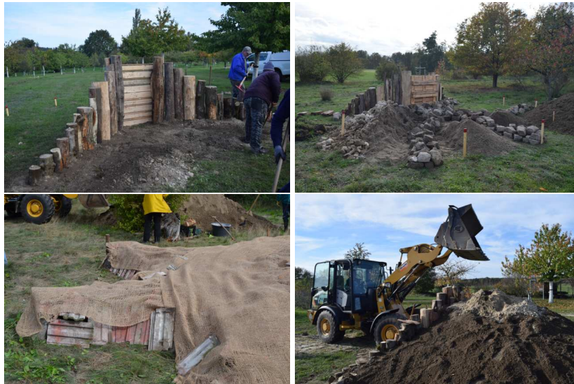
Abbildung 6: Bienenburgenbau in der Lausitz. Bauabschnitte: Setzen der Palisaden (oben links), Setzen und Abdecken des Steinkerns (oben rechts und unten links), Aufbau des Hügels (unten rechts).
