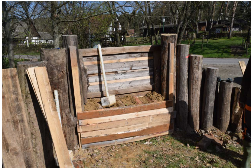
Abbildung 7: Bienenburgenbau in der Lausitz - Lehmwandbau.
